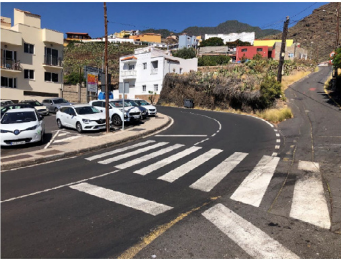
Fotografía 1. Detalle estado actual paso de peatones en tramo en curva de acceso a la zona de estacionamiento frente al colegio.
