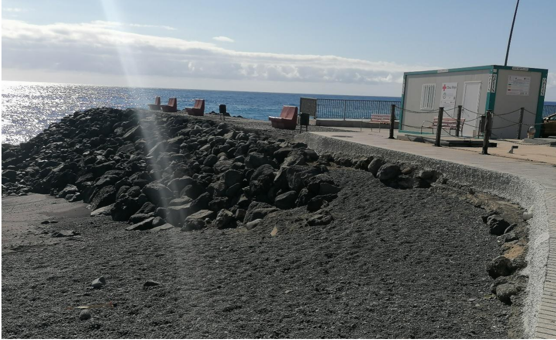
(Inexistencia de valla de seguridad que evite posibles caídas sobre las piedras de la escollera y ante el gran desnivel existente entre el paseo y la playa)
