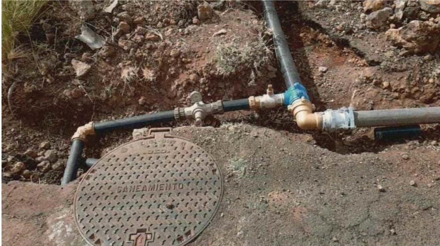
Se realizó la conexión de 6 acometidas, con tubería de polietileno de 25 mm, PN-16, existentes en la renovación del tramo de la red.
