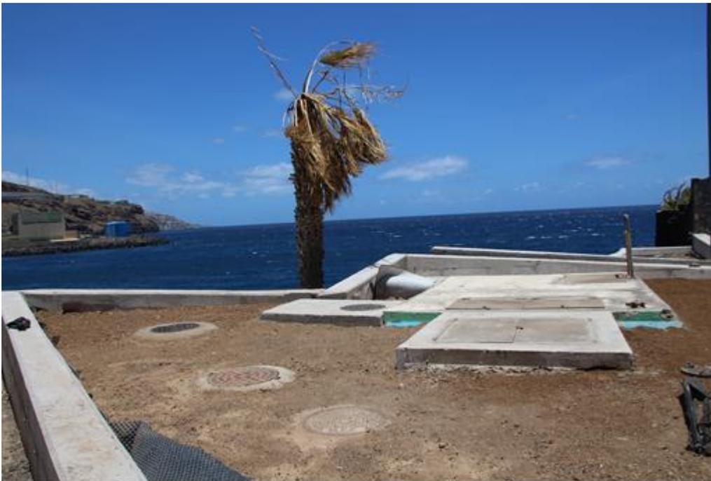
Se sustituyeron dos arquetas: una de 1,18 x 0,98 metros y tapa de una hoja formada por bastidor de perfil de 40x40x2 mm y chapa estriada de 3 mm de espesor. Perfiles en acero inoxidable 316 y chapa de acero inoxidable 304. Y otra arqueta de 1,418 x 1,38 metros y tapa de dos hojas formada por bastidor de perfil 40x40x2 mm y chapa estriada de 3 mm de espesor. Perfiles en acero inoxidable 316 y chapa de acero inoxidable 304.
