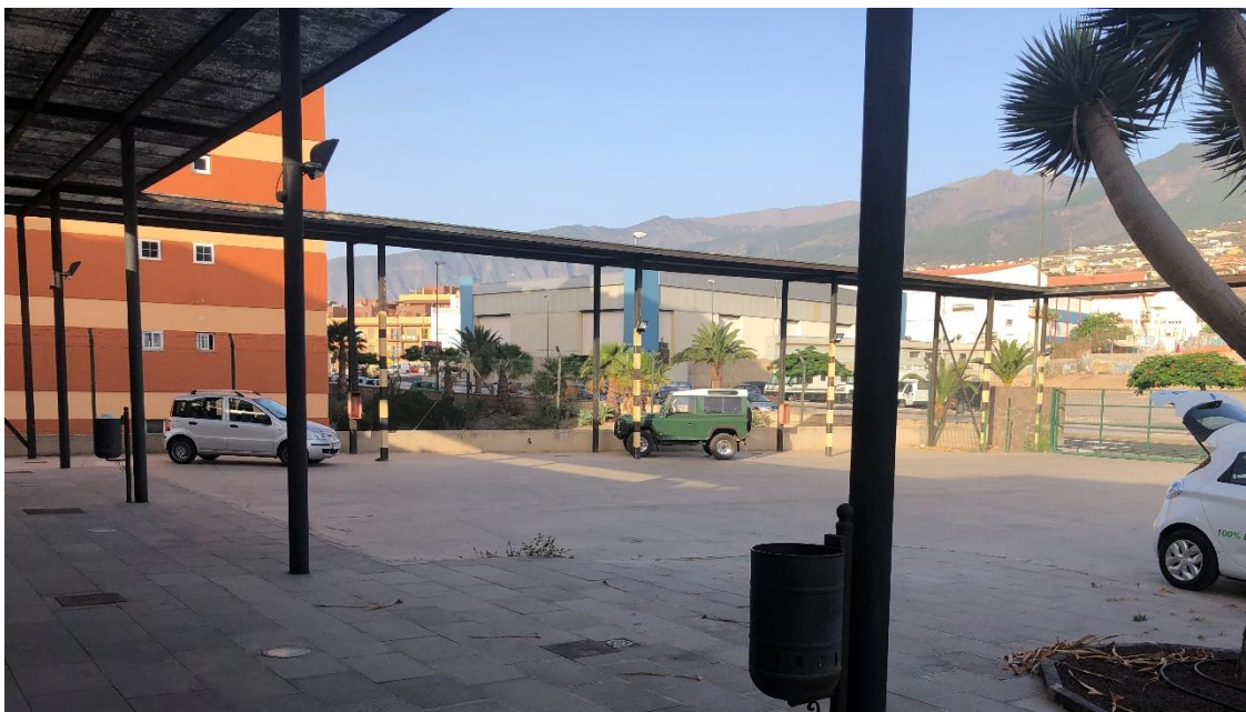
Vista de la zona de dársena
