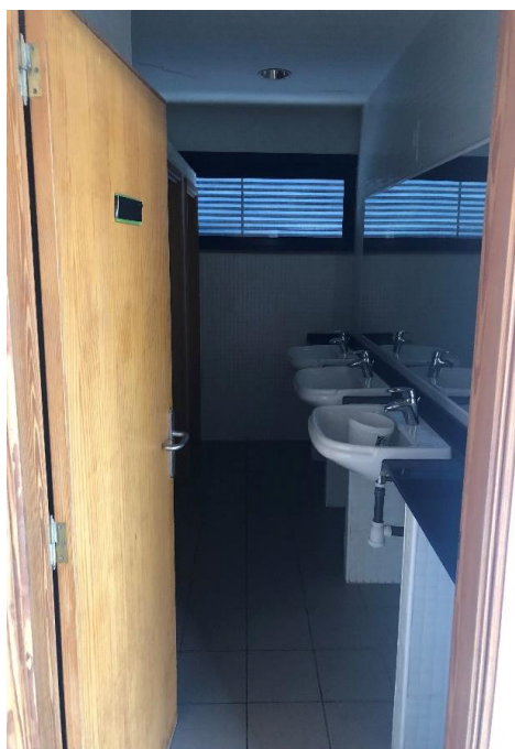
Interior del baño masculino
