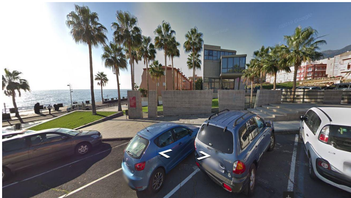
Fachada calle Pasacola
