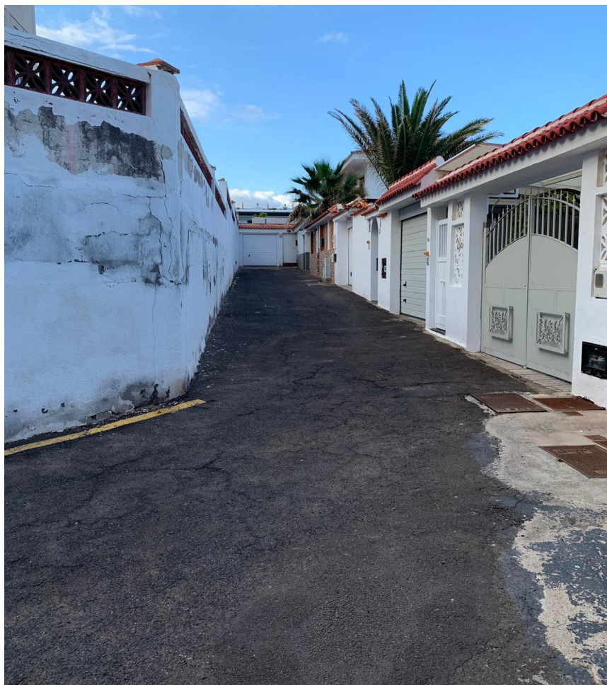
Tramo final de la calle
