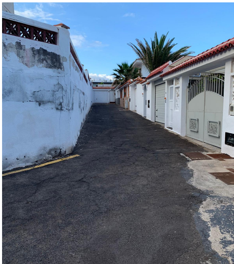
Tramo final de la calle
